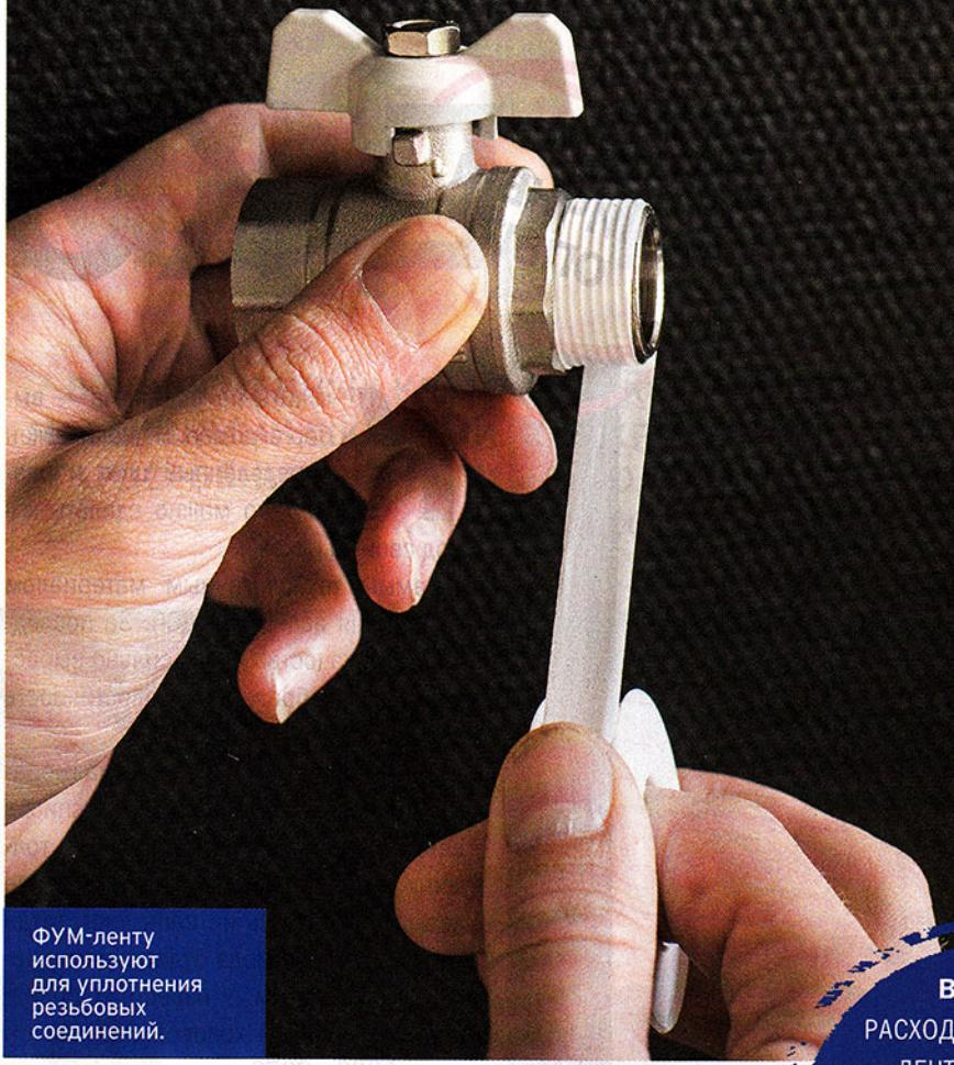
ФУМ-ленту используют для уплотнения резьбовых соединений.
